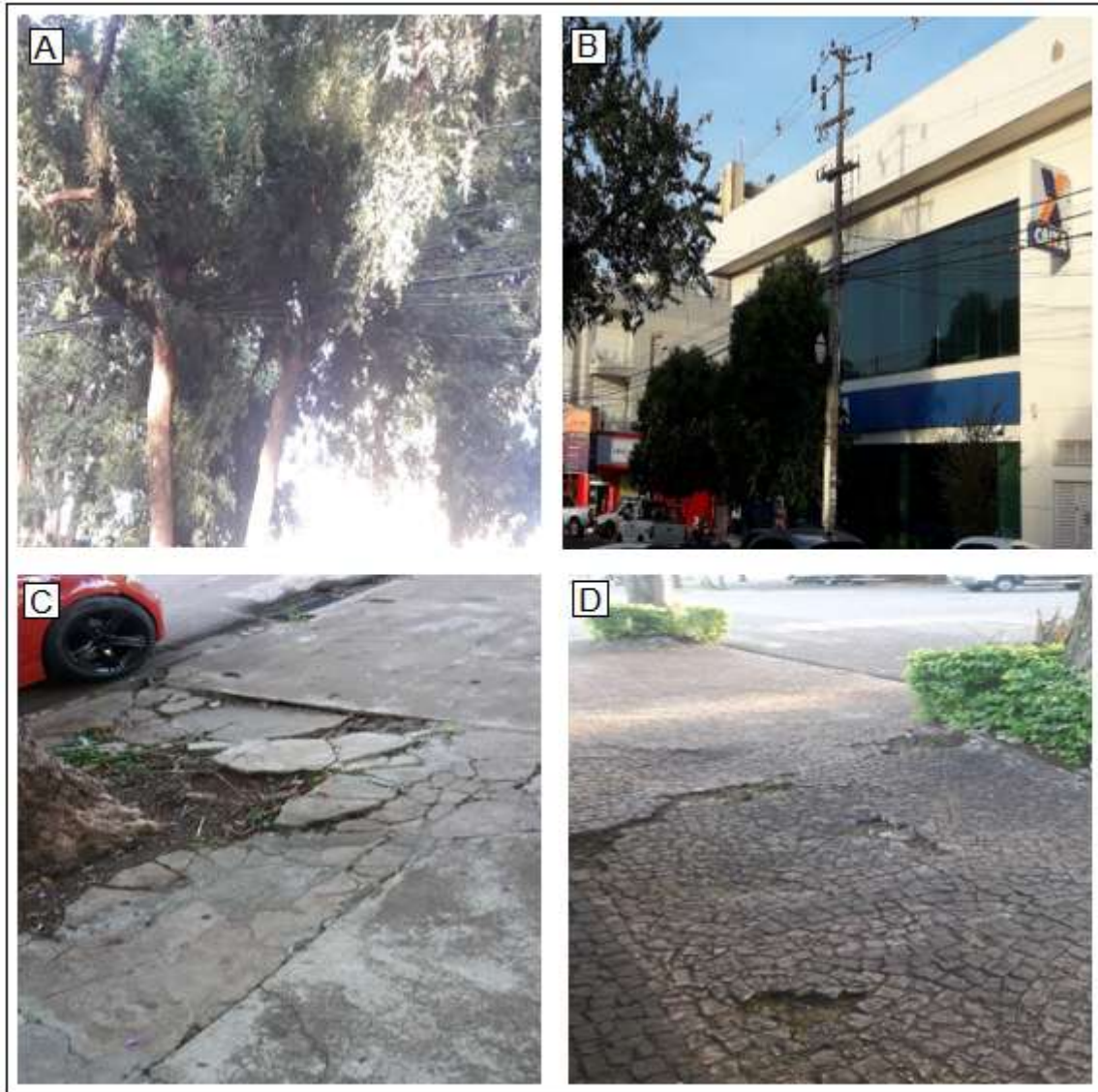
Figura 3 – Exemplos dos conflitos das árvores com a fiação e a calçada
