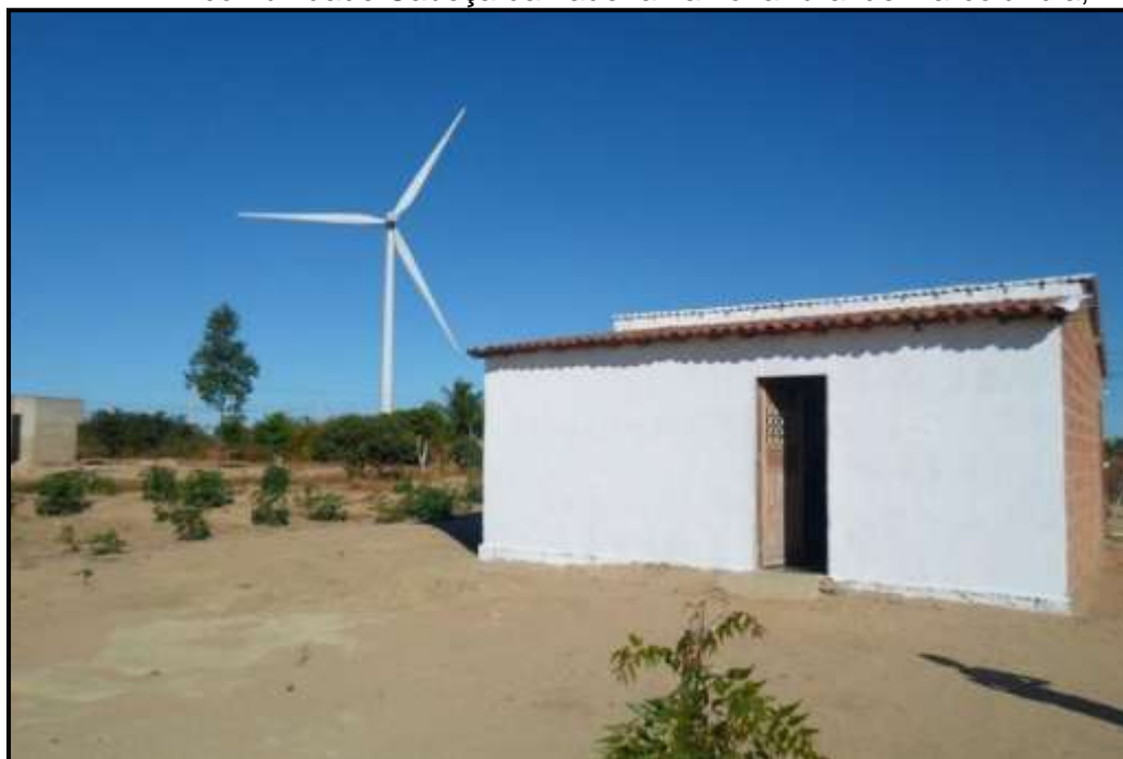
Figura 8 - Presença de aerogerador no quintal de uma residência na comunidade Cabeça da Ladeira na zona rural de Marcolândia, PI
