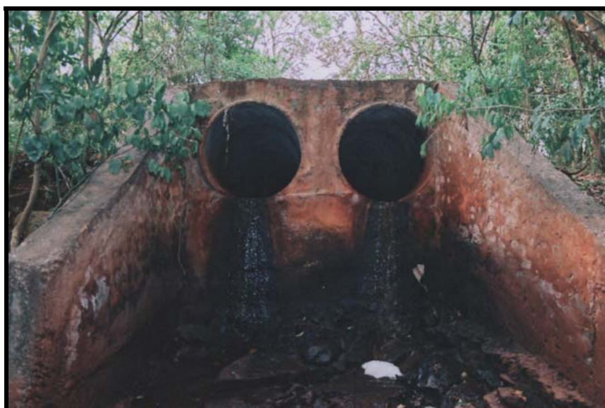
Figura 8 - Chorume desaguando no córrego dos Piriquitos através de canalizações. Data: 2007. Fonte: Rodrigo Vitor B. Sousa.
