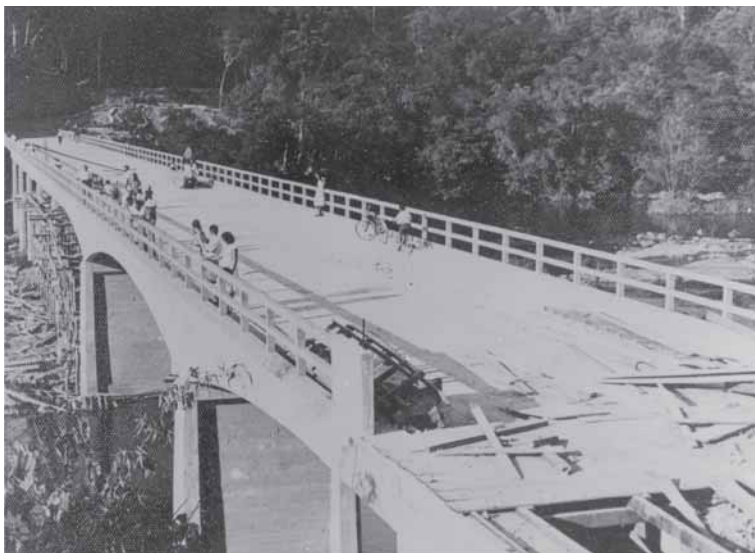
Figura 2 – Construção da ponte sobre o rio Tibagi
