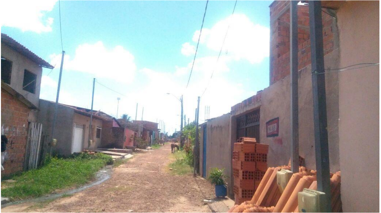
Figura 01: Ausência de serviços básicos de saneamento na área
