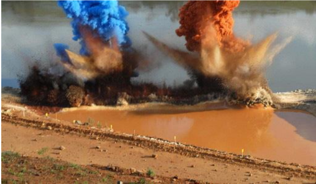
Figura 40: Detonação de explosivos para desvio do rio Tibagi. Fonte: PARANÁ, 2009
