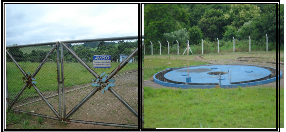
Figura 33: Estação de tratamento de esgoto da SANEPAR. Autora: Fukuda, 2009.
