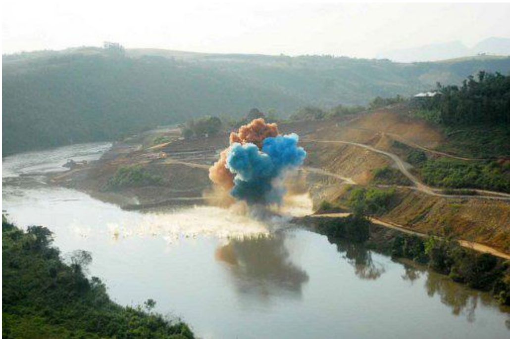
Figura 41: Detonação de explosivos para desvio do rio Tibagi. Fonte: PARANÁ, 2009.
