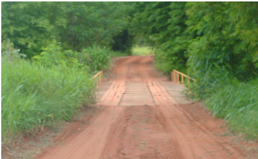
Estrada sem pavimentação que liga a cidade de Presidente Venceslau aos assentamentos Tupanciretã e Primavera.
