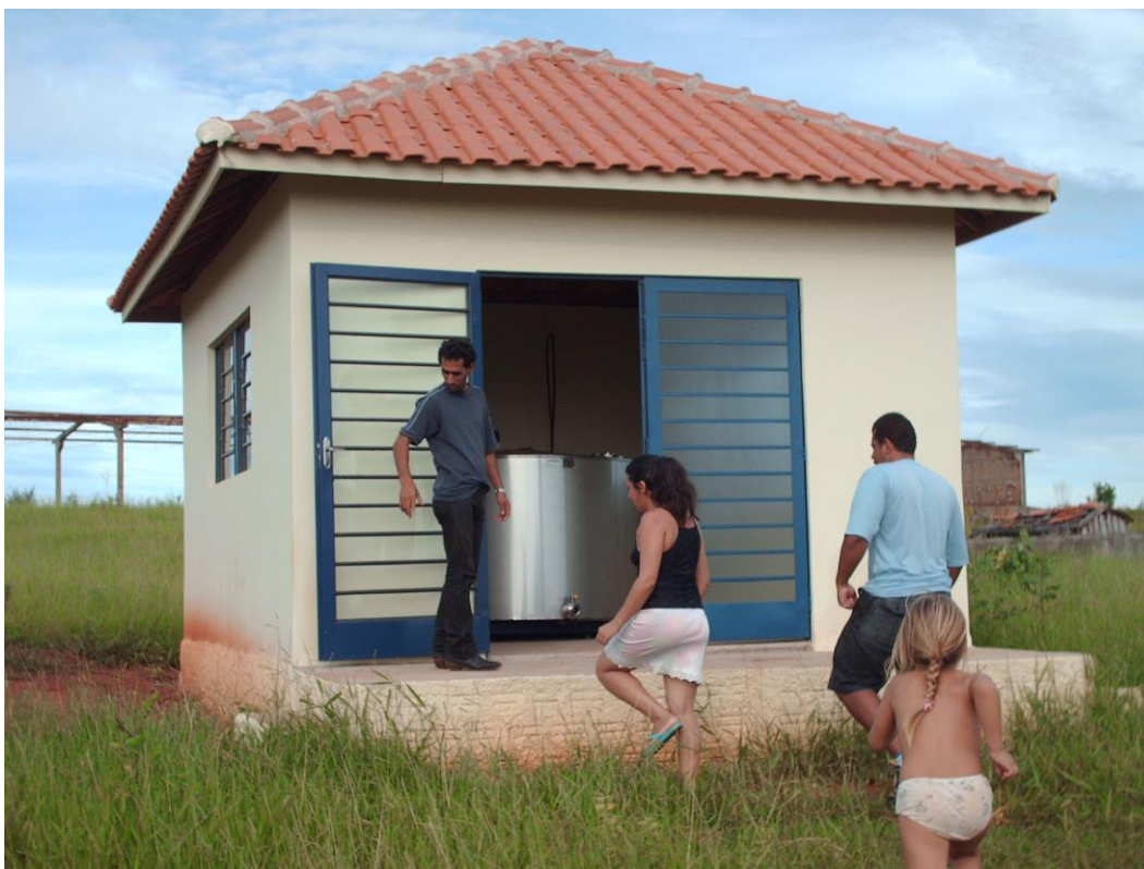
Tanque de resfriamento do leite doado pelo Ministério do Desenvolvimento Agrário e Administrado por Salomé, membro da Associação Campos Verdes do Primavera.
