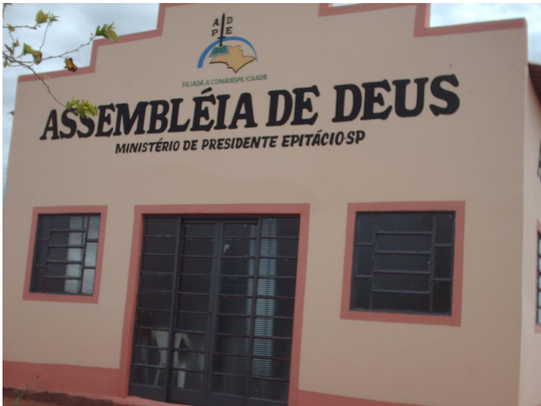
Templo da Assembléia de Deus do Primavera I construída no lote do Pastor Izael.
