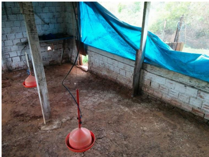
Figura 1: Vista da parede lateral do aviário
