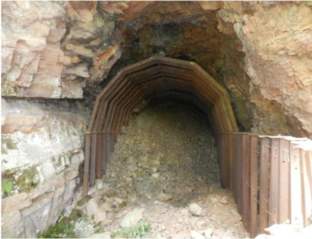
**Figura 1: Abertura do Túnel Ferroviário do lado lacrado pelo desabamento.**
