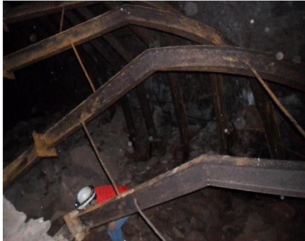
**Figura 2: Detalhe da estrutura de sustentação retorcida pelo desabamento. Autoria: Patrícia Perrud Silva, 2013.**
