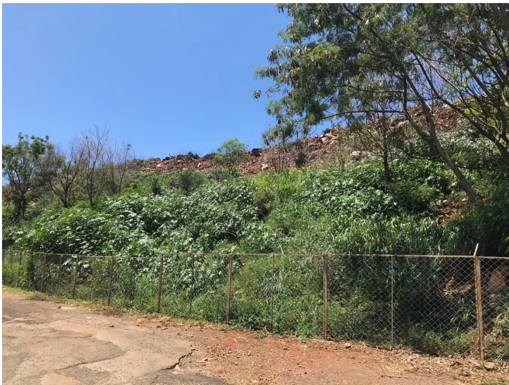
Figura 17 – Talude ao lado da estrada na antiga Pedreira Urbasa.
