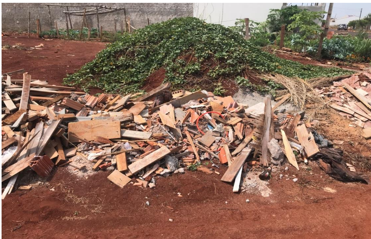
Figura 20 – Deposição Irregular em terreno baldio. Fonte: o próprio autor, 2019.
