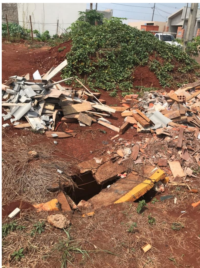
Figura 25 – Deposição de RCC próximo à drenagem. Fonte: o próprio autor, 2019.
