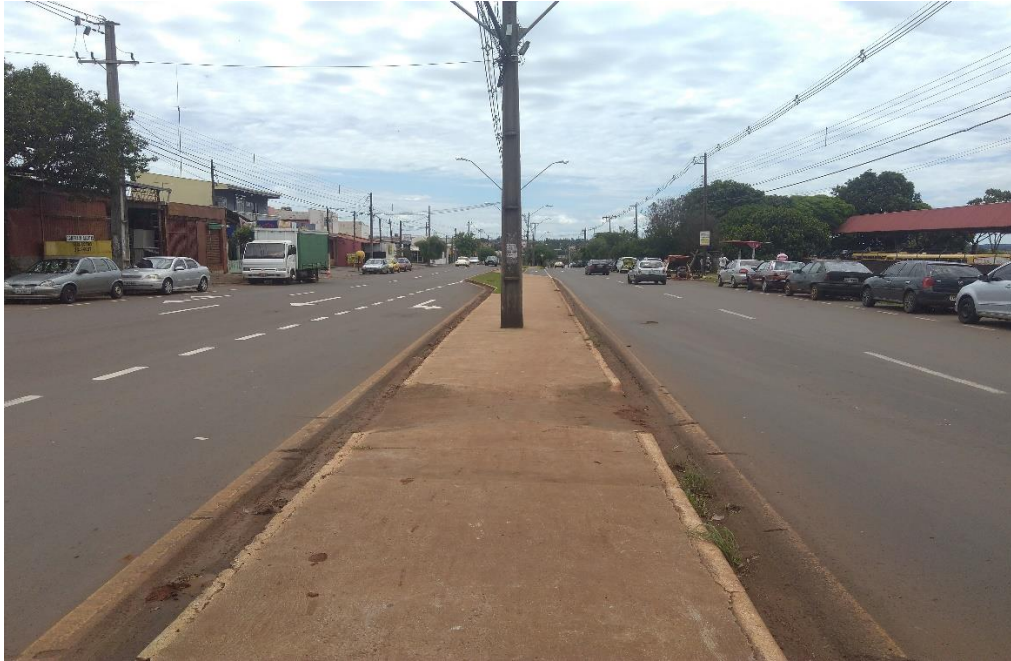
Figuras 22 e 23 – Via e cruzamento sem sinalização
