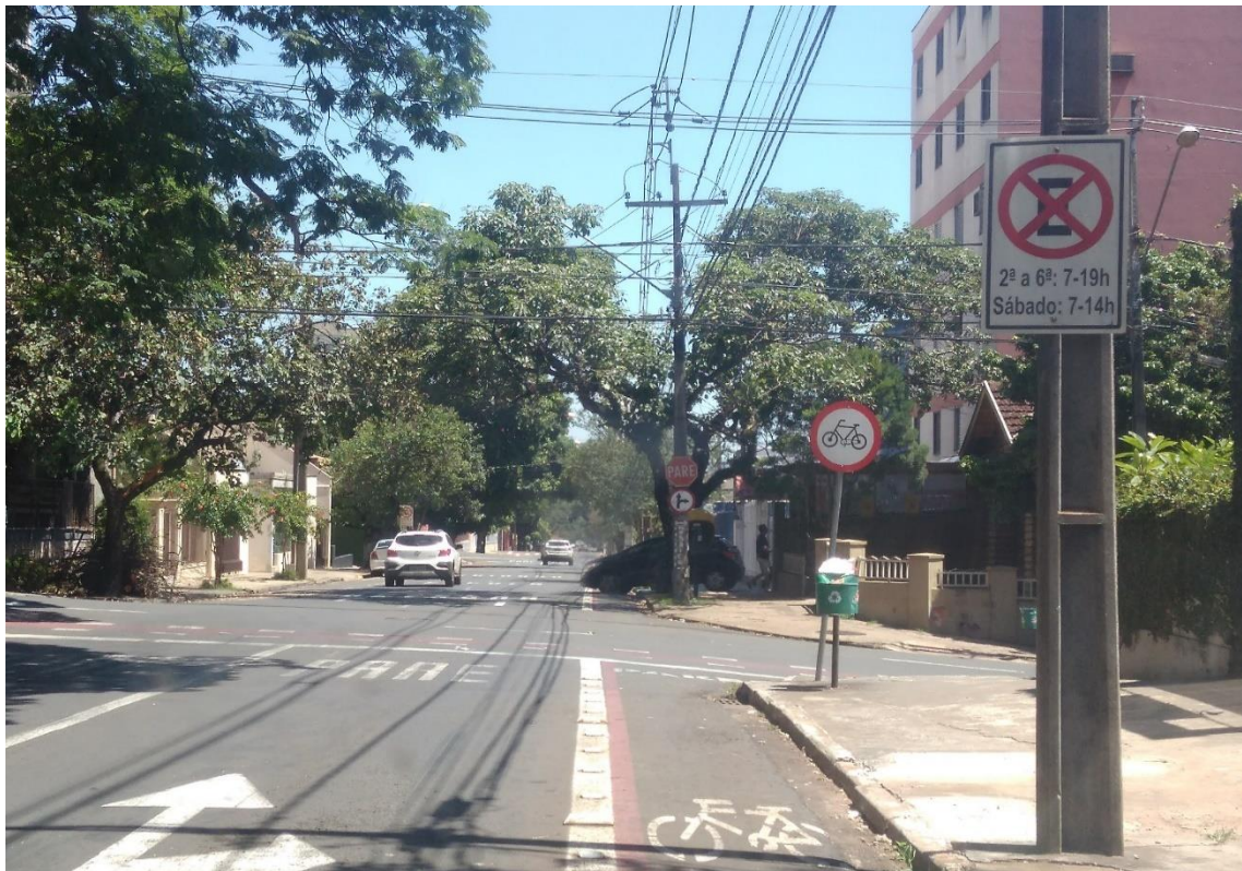
Figura 24 – Ciclofaixa como via limitada
