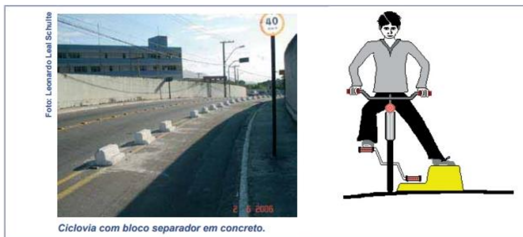
Figura 6 - Ciclovía Segregada junto à Via
