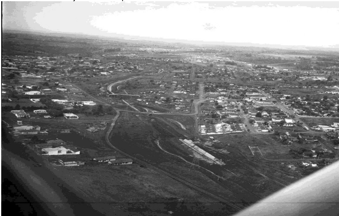
FIGURA 8- Construção da Via Expressa
