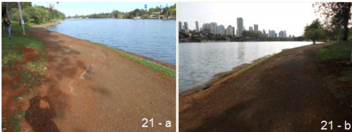
Figura 21 – Erosão na pista de caminhada
