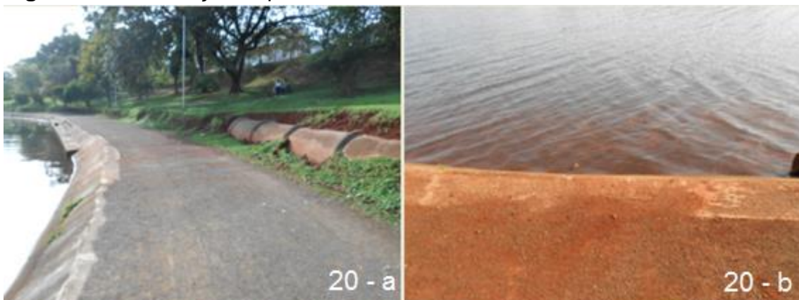
Figura 20 – Tubulação Exposta
