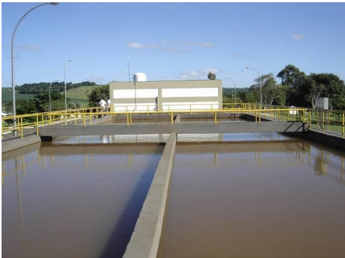
Figura 12 - Estação de Tratamento de Água do Tibagi.
