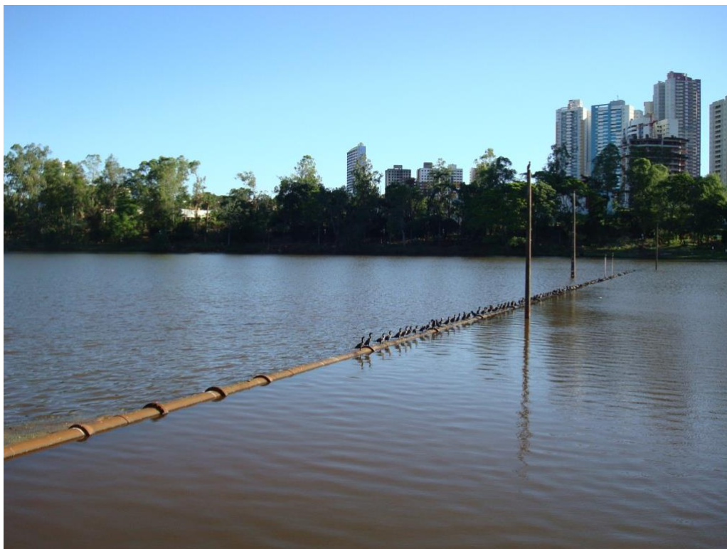
Figura 13 . Adutora de água bruta Cafezal
