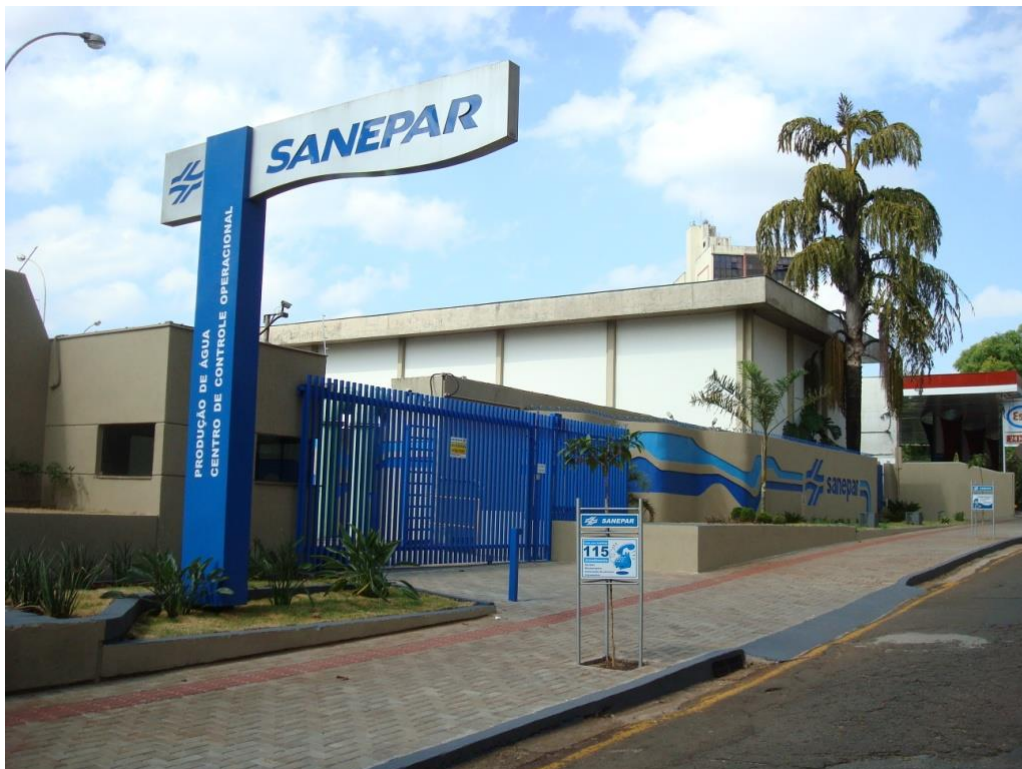
Figura 14 . Centro de Controle Operacional do sistema de distribuição de água tratada.
