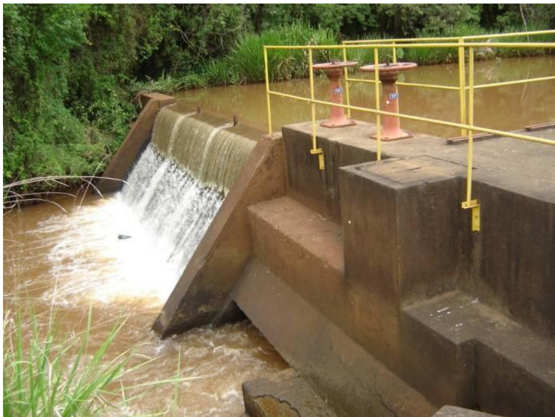
Figura 11 -Barragem para captação de água do Ribeirão Cafezal.
