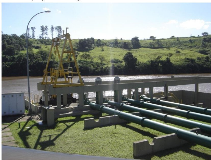
Figura 16 . Detalhe na captação do Tibagi
