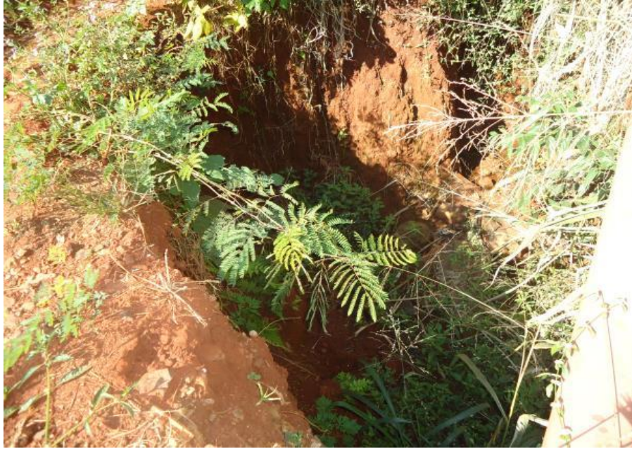
Figura 27 – Erosão em área de Preservação do córrego Tucanos. Fonte: CARDOSO, Priscila M.
