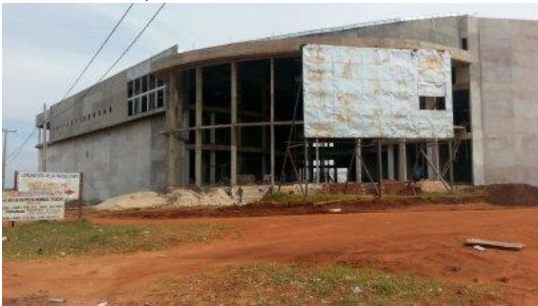
Figura 30 – Vista parcial da construção de um estabelecimento comercial em Salto Del Guairá-PY, 2013
