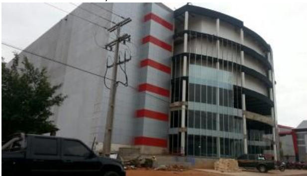
Figura 27 – Vista parcial da construção de um estabelecimento comercial em Salto Del Guairá-PY, 2013
