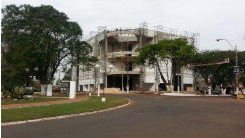
Figura 29 – Vista parcial da construção de um estabelecimento comercial em Salto Del Guairá-PY
