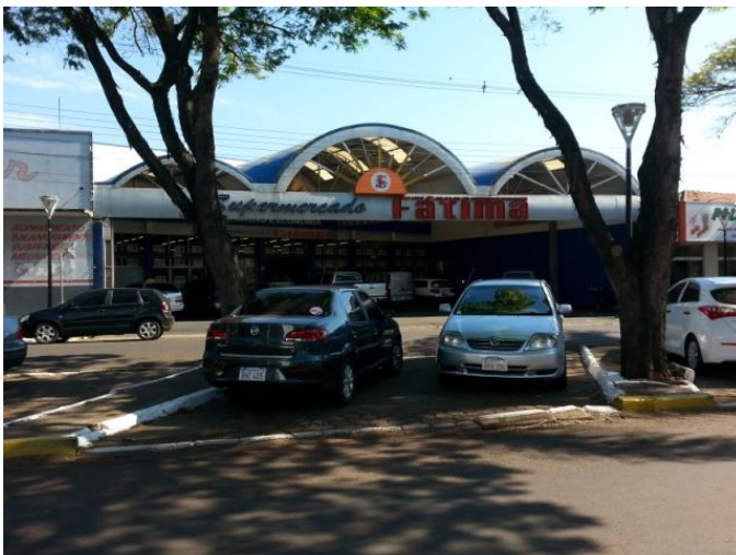
Figura 9 – Vista parcial do supermercado Fátima em Guaíra-PR, 2013
