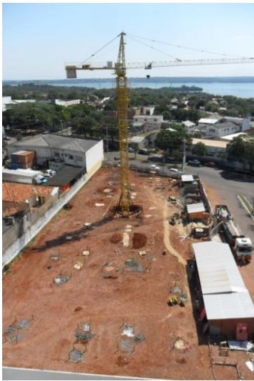
Figura 17 – Início da construção dos edifícios do Empreendimento Torres de Toscana em Guairá, 2013
