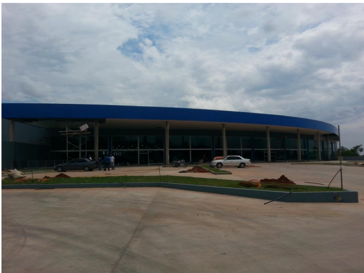
Figura 31 – Vista parcial da construção de um estabelecimento comercial em Salto Del Guairá-PY
