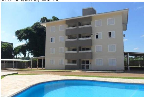
Figura 16 – Vista parcial de um dos blocos do Parque Residencial das Cerejeiras em Guaíra, 2013
