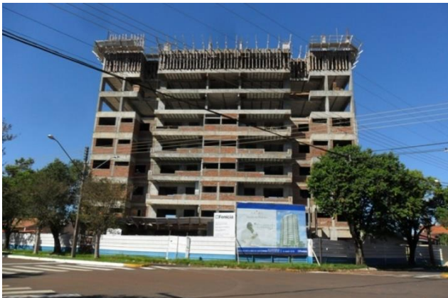
Figura 15 – Vista parcial da construção do edifício Torre de Nápolis em Guaíra, 2013
