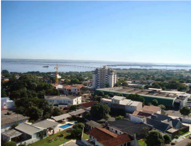
Figura 14 – Vista parcial do Edifício Florenzane Guaíra, 2013
