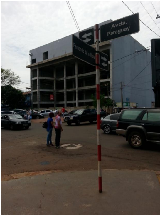
Figura 32 – Vista parcial da construção de um estabelecimento comercial em Salto Del Guairá-PY
