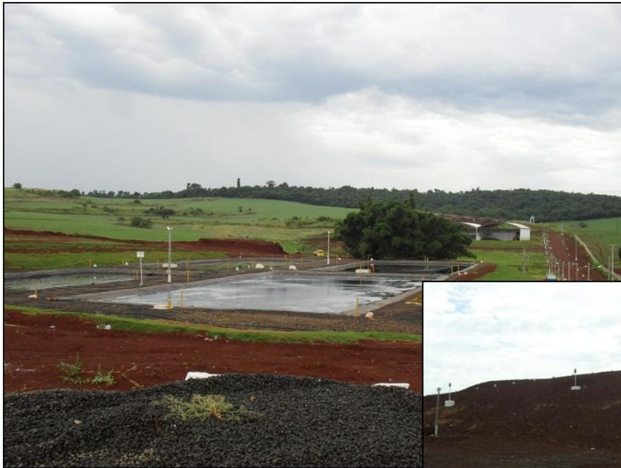
Visão parcial da célula com lixo coberta com material argiloso e dos pontos de captação de gases (foto menor à direita).
