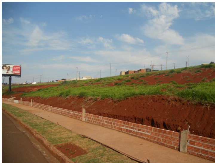
Figura 18 - Calçamento com grama (aproximação de uma calçada ecológica) e muretas perto da margem do lago.
