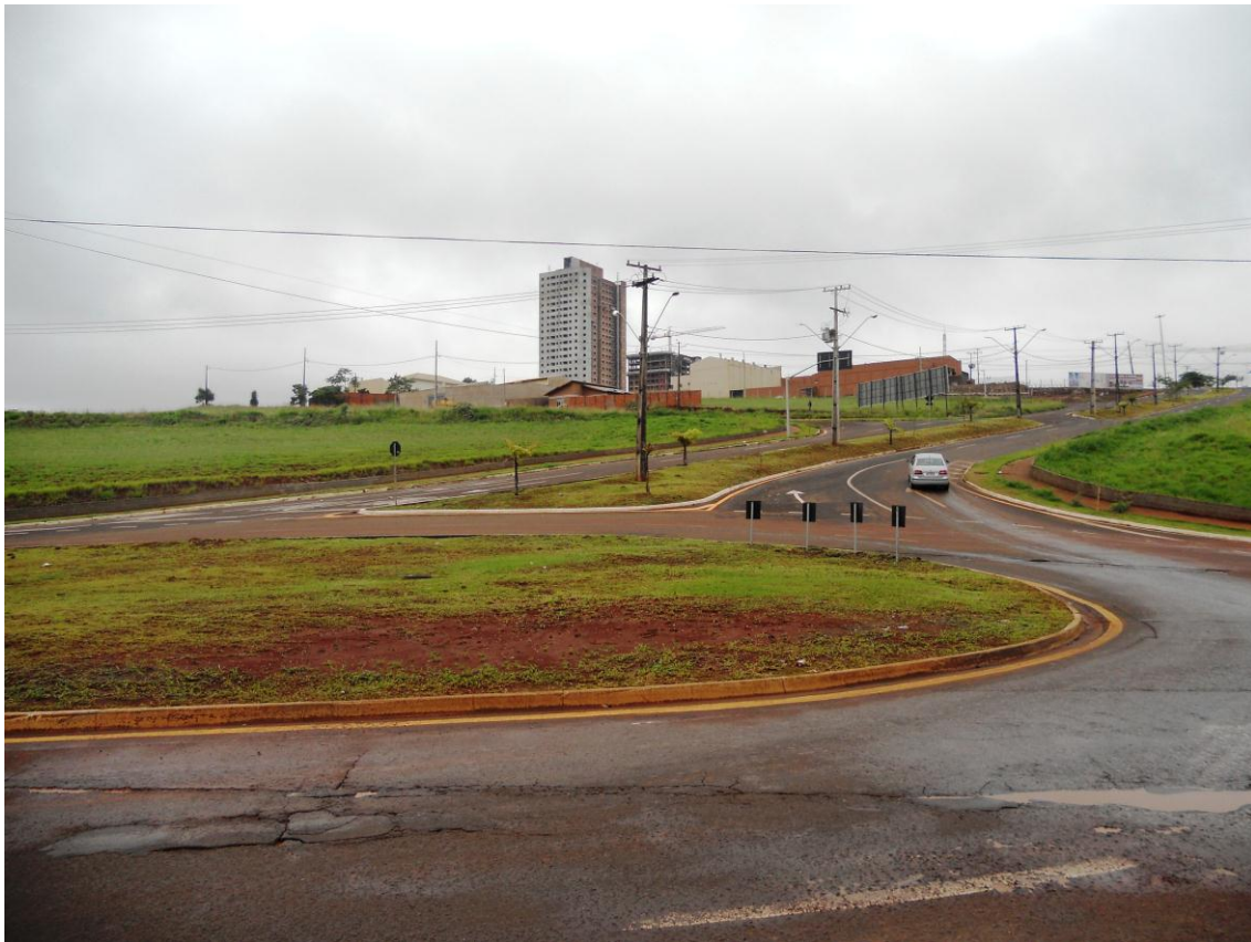
Figura 13- Zona de depósito de sedimentos na rotatória onde se cruzam a avenida Castelo Branco e a avenida Aniceto Espínola. Vale lembrar que esta área possui pontos de inundação. Fonte: Pedro Höfig, 2012.
