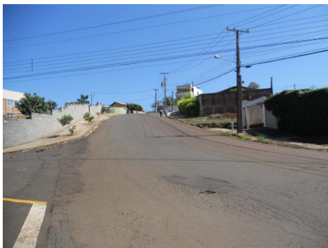
Figura 4 - Cruzamento das ruas João Sanches e João Vicente, próximo ao córrego Baroré, onde a classe de solos inferida é a dos Cambissolos. A imagem permite verificar que quase a totalidade da área apresenta-se construída e asfaltada. Fonte: Pedro Höfig, 2012.
