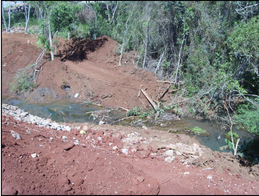
Fotografia 06: Obra de transposição do Córrego Barreiro.
