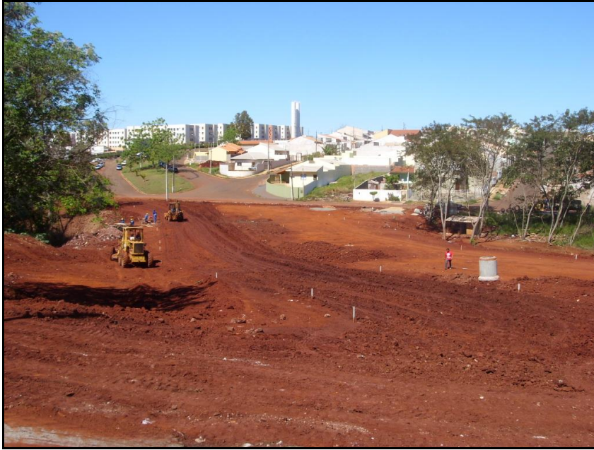
Fotografia 04: Obra de transposição do Córrego Barreiro. Fonte: Autora.
