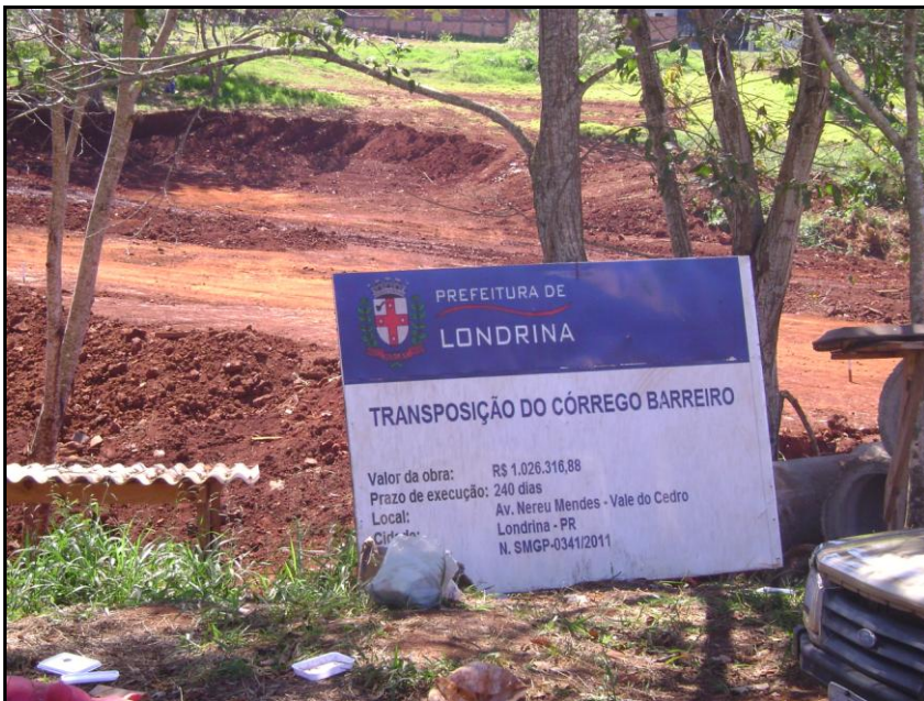
Fotografia 05: Obra de transposição do Córrego Barreiro. Fonte: Autora.
