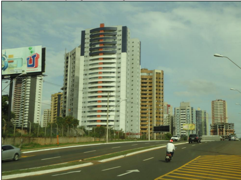
Figura 22: Avanço das edificações próximo à região de fundo de vale do ribeirão Cambé.
