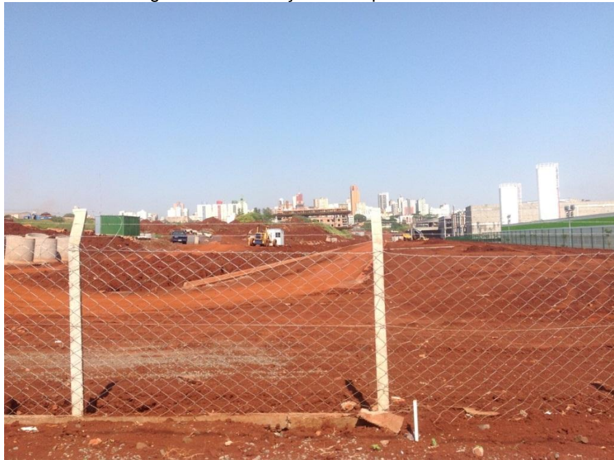
Figura 16: Construção do empreendimento.
