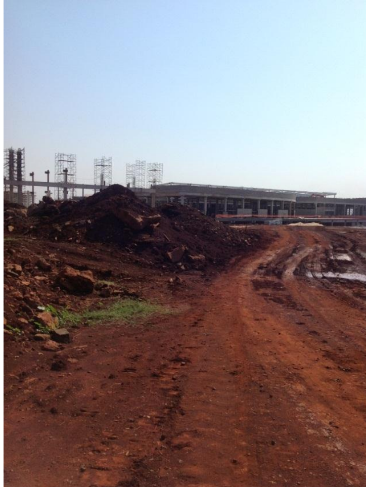
Figura 18: Andamento das obras no Complexo Marco Zero.
