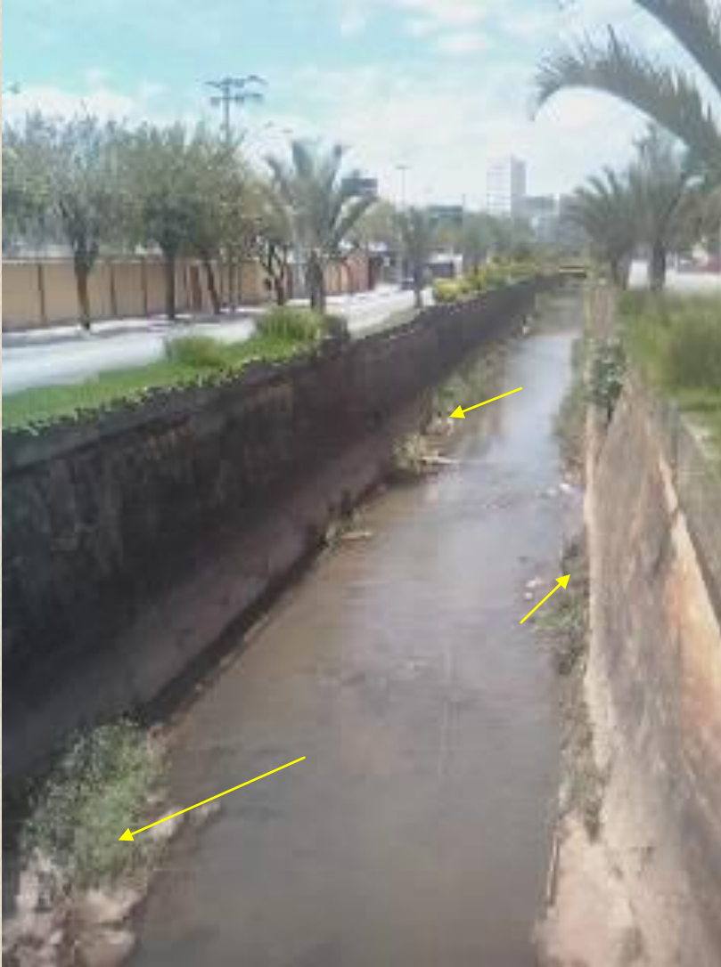
Figura 7: Rio Carambeí em percurso urbano – Avenida Antonino Dias Bastos – acúmulo de resíduos nas laterais do canal.
