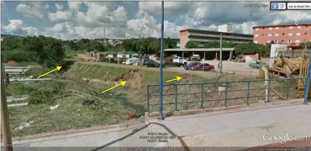
Figura 23: vertente do Rio Marmeleiro – depósito de materiais de construção – erosão e acúmulo de resíduos.
