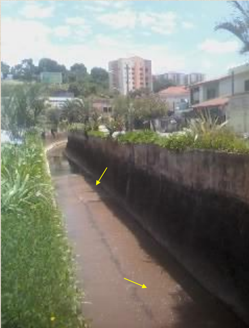
Figura 8: Rio Carambeí em percurso urbano – Avenida Antonino Dias Bastos- acúmulo de sedimentos na lateral do canal retificado Fonte: Gilberto Chagas - 25/10/11
