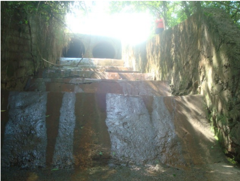
Foto 06 – Galeria pluvial localizada a aproximadamente 200 metros da nascente. GUILHEM, 2011.
