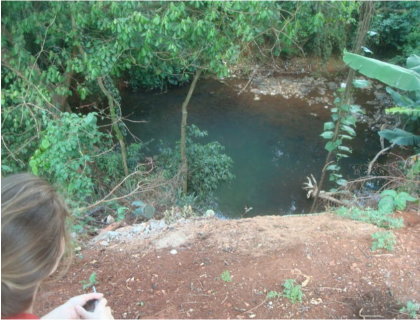
Foto 04 – Entulho colocado para conter deslizamento. GUILHEM, 2011.
