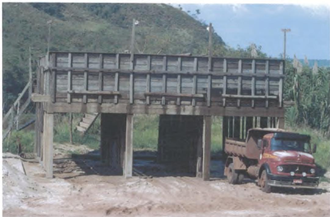
FOTO 2 – Silo de desaguamento onde a areia é armazenada e posteriormente colocada em caminhões para o transporte. (Min. A. Martins)
